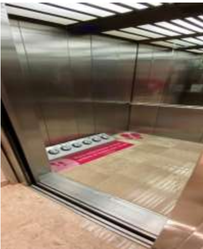
Figura 45. Comando y botones accesibles pensados en el alcance de usuarios de sillas de ruedas
