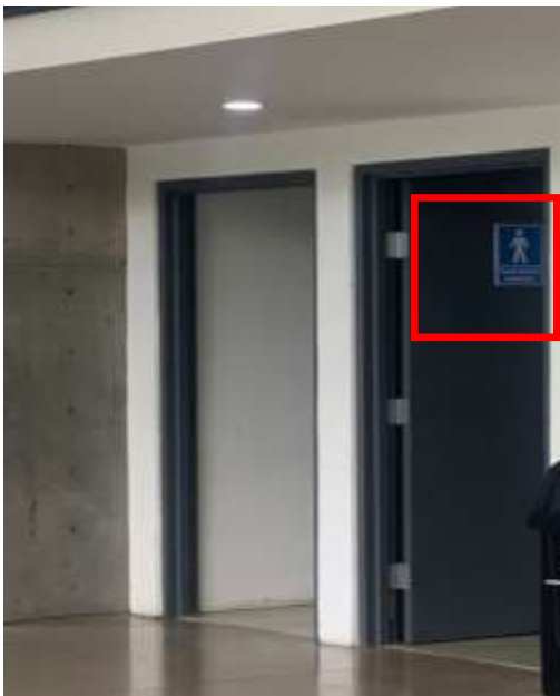
Figura 50. Error de ubicación en señalética, en formato pequeño y sobre una base móvil (la puerta), que provoca que, al abatirla, la información se pierda, generando confusión Fuente: Elaboración propia (2025)
